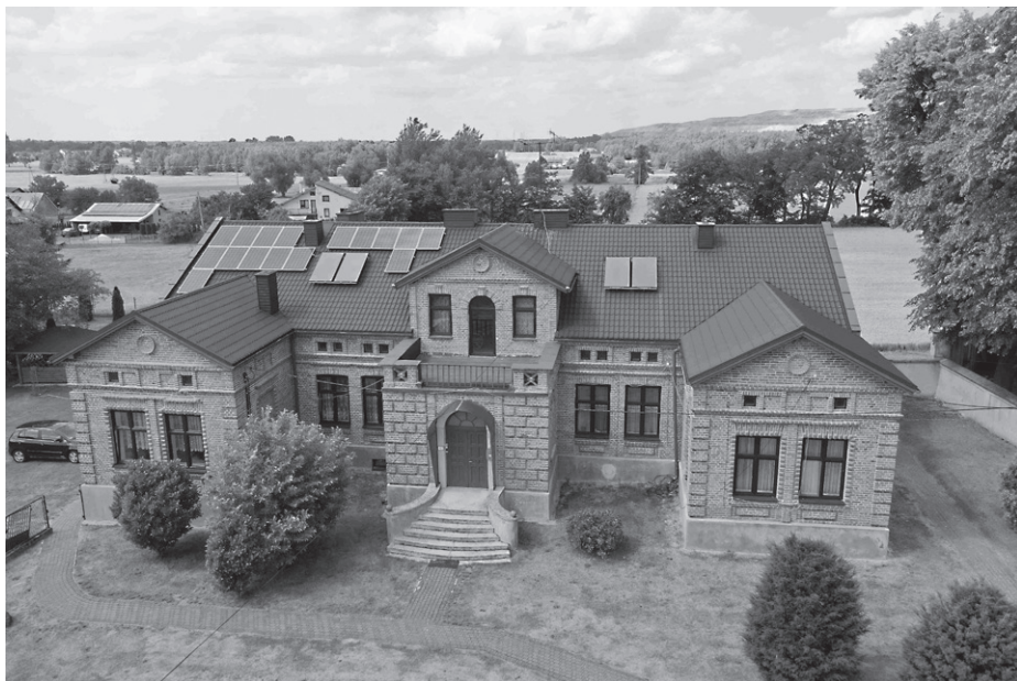
Plebania w Rzaśni z 1907 r. od strony południowej, stan z 2024 r.
